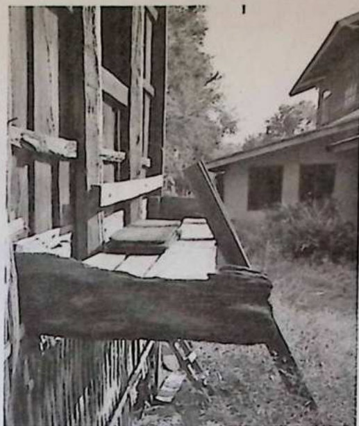
กะทอดเล้าเป็นลานยื่นออกมาทางด้านหน้าของเล้า มีบันไดที่ใช้ขึ้นลง เป็นบันไดลอย ที่เคลื่อนย้ายออกได้
