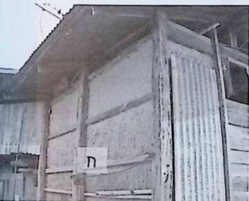
ก. เล้าข้าวที่มีฝาเป็นไม้ไผ่ยาหรือฉาบด้วยดินเหนียวและขี้ควาย
